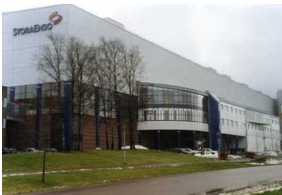
Stora Enso, byggnad för KM 8, Skoghall
